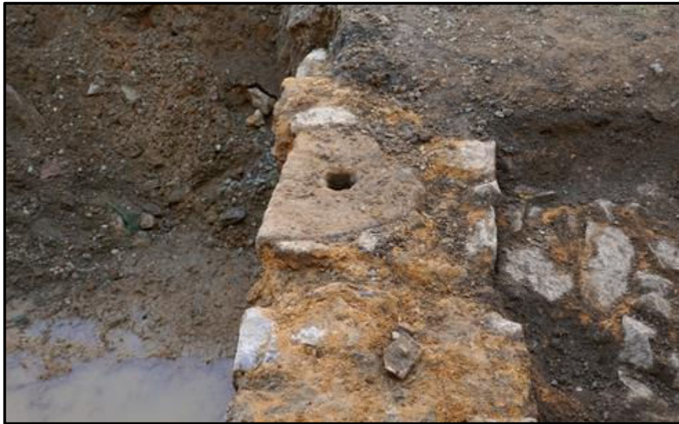
Sondages dans le sol de la cour entre l'église et le prieuré : emploi d'une meule dans les fondations d'une construction ancienne (Photo JMA)
