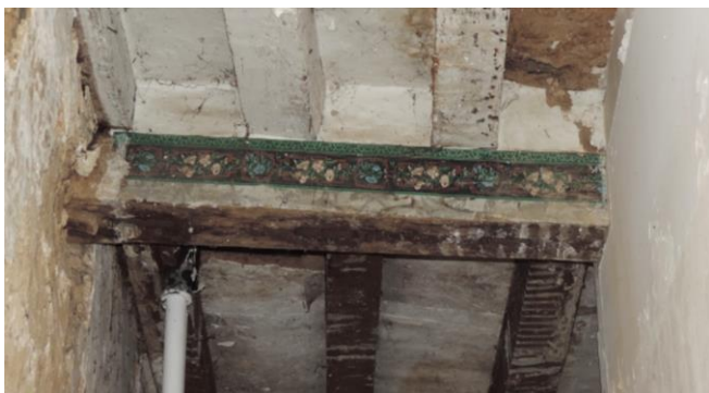
La frise avant la déconstruction de la cloison latérale du couloir
