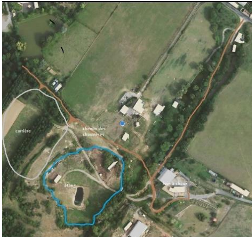
Implantation du four et ses ressources en eau et en pierre (Google Maps)
